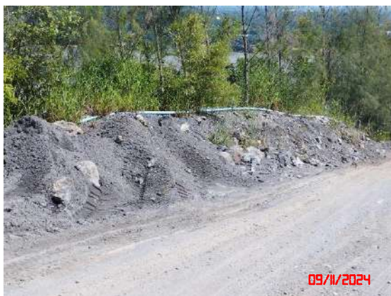
รูปที่ 15 คันทำนบดิน และคูระบายน้ำ
