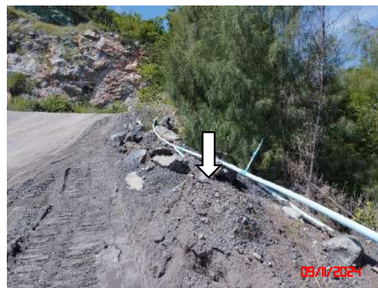
รูปที่ 15 คันทำนบดิน และคูระบายน้ำ
